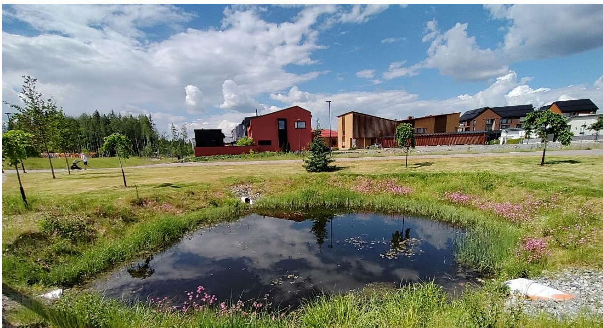
Yleiselle alueelle rakennettu hulevesiallas kuuluu kunnan hulevesijärjestelmään. Allas kerää tonteilta johdettavia hulevesiä ja sen kunnossapidosta vastaa kunta. Kuva: VHVSY
