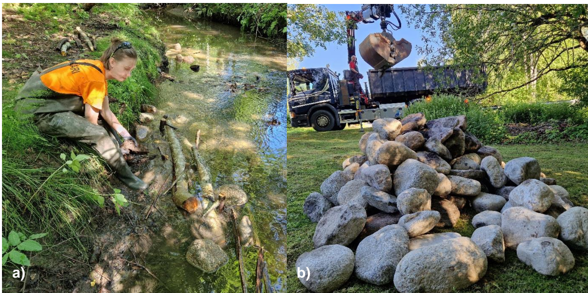
Kuva 8. a) Suninen kiinnittämässä puumateriaalia purouomaan ja b) saapuva kivikuorma. (Tiusanen, 2023.)
