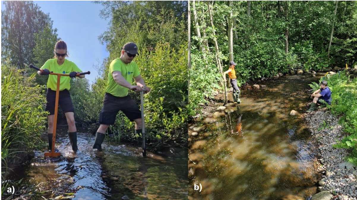
Kuva 7. a) Suninen (vas.) ja Haaranen kuohkeuttamassa soraikkoa soraporilla ja b) purotalkkarit valmiilla soraikolla (Tiusanen, 2023).
