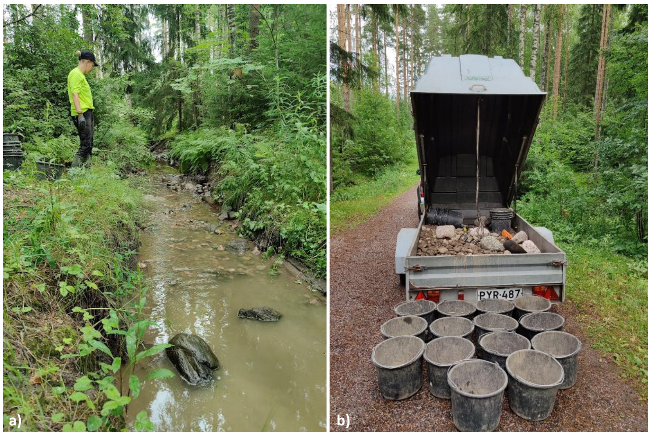
Kuva 34. a) Tervaojan uusi kutusoraikko (Pte00) ja b) soraikon rakentamiseen käytetyt työvälineet ja osa kivimateriaalista. (Laurila, 2022)
