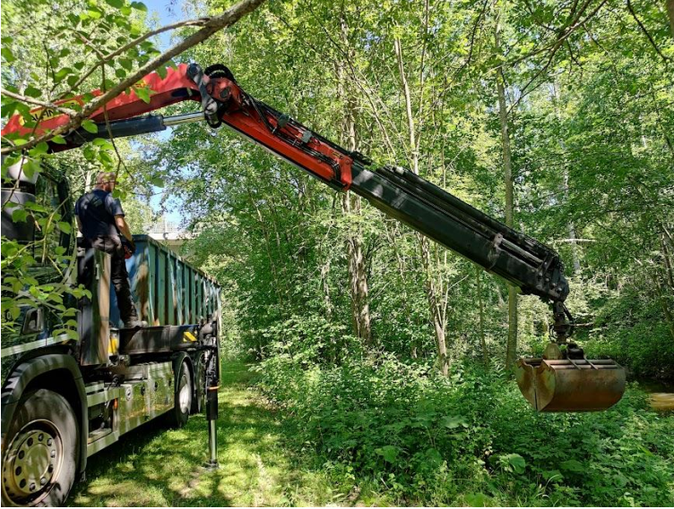
Kuva 29. Kutusoraa ja poikaskiviä nostetaan suoraan Rekolanojaan kuorma-auton lavalta kouran avulla. (Laurila, 2022)
