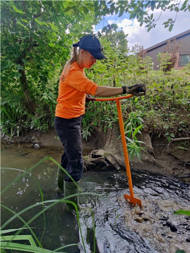
Kuva 24. Hietanen kuohkeuttaa soraporalla kutosoraikkoa Kylmäojassa. (Laurila, 2022)
