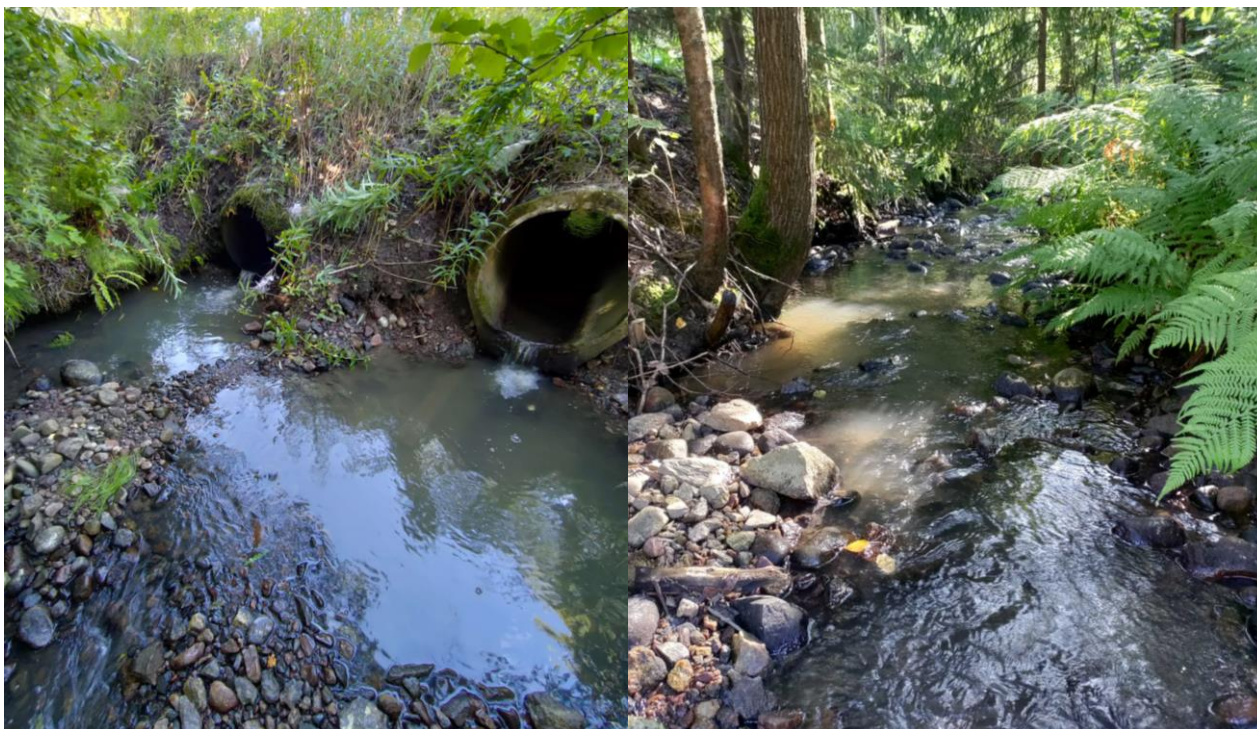
Kuva 11. Myrtinoja 3 -virtapaikan tierumpu on noususte alavirran puolelta (vasen). Tierummusta alavirtaan uoma alkaa meanderoita ja poikasalueet ovat hyvät (oikea).
