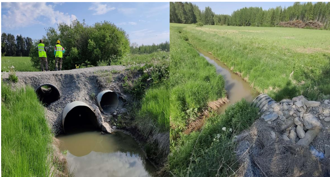
Kuva 7. Virtaamavaihtelut ovat Kurtojalla suuria ja paikallisten mukaan Kurtoja tulvii voimakkaasti talviaikaan. Tulvavedet ovat kuluttaneet uomaa ylittäviä teitä Helsinki-Hämeenlinna moottoritien yläpuolella.
