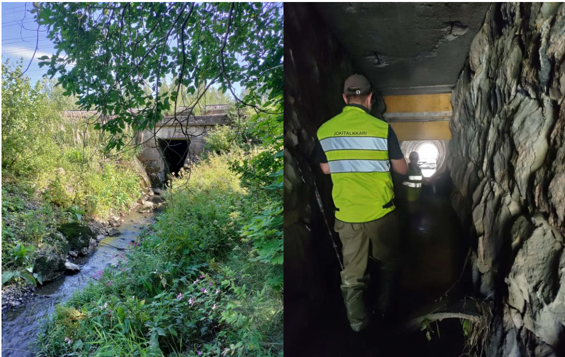
Kuva 14. Myrtinoja 4 -virtapaikassa on potentiaalia kunnostamiseen (vasen). Virtapaikan yläpuolella Myrtinoja kulkee junaradan ali tunnelissa, jossa on pudotuksen takia nousueste kaloille (oikea).
