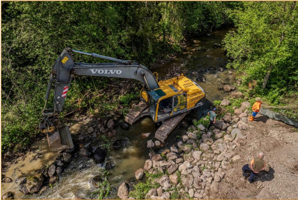
Kuva 4. Vanhanmyllynkosken kunnostuksessa käytetty kaivinkone avaamassa vanhaa perkuuvallia kesäkuussa 2024.
