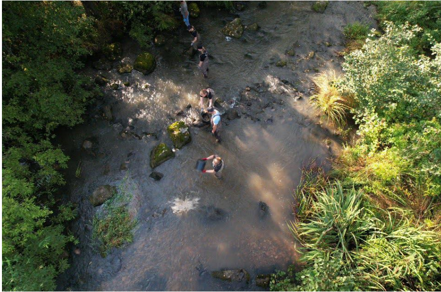
Kuva 8. Hanabölenkoskeen rakennettiin uusia kutusoraikkoja käsivoimin.
